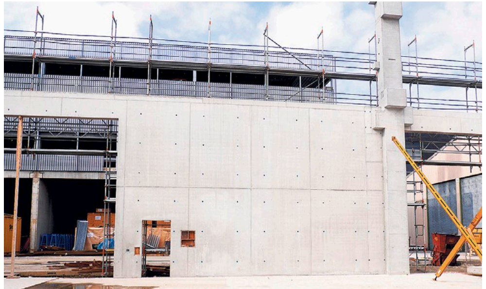
Le progrès concerne également le secteur de la construction: cette paroi haute de 7,25 m en béton autoplaçant a été coulée d'un seul tenant, en une heure. Photo: www.meva.ch
